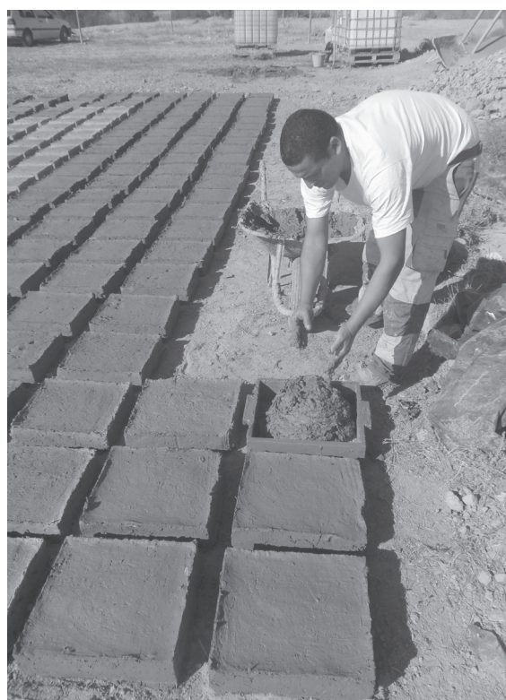
Figura 4. Tovots de les mateixes mides que els recuperats a l'excavació, realitzats amb motllos de fusta.
