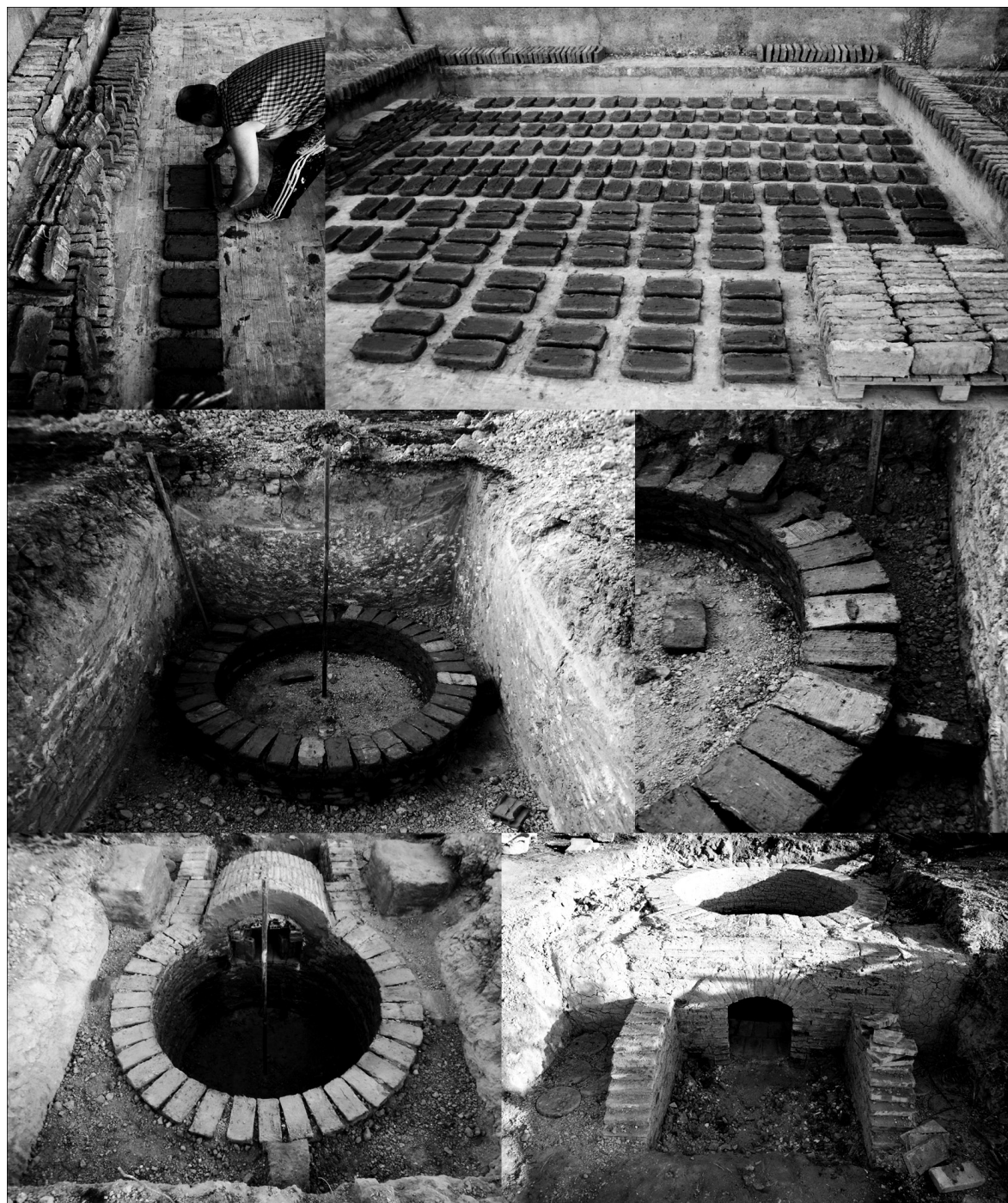
Figura 3. (Arriba) Secuencia de producción de adobes. (Abajo): Secuencia de construcción experimental de la cámara de combustión o praefurnium. (Foto: Autor).
