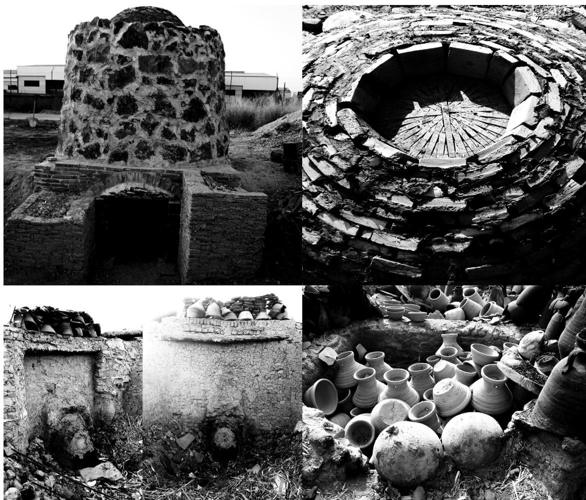
Figura 5. (Arriba): Secuencia de construcción de la cubierta permanente. (Abajo): Horno cerámico que carece de cubierta permanente, ubicado en la comunidad alfarera egipcia de Ehnasya el Medina. (Foto: Autor).
