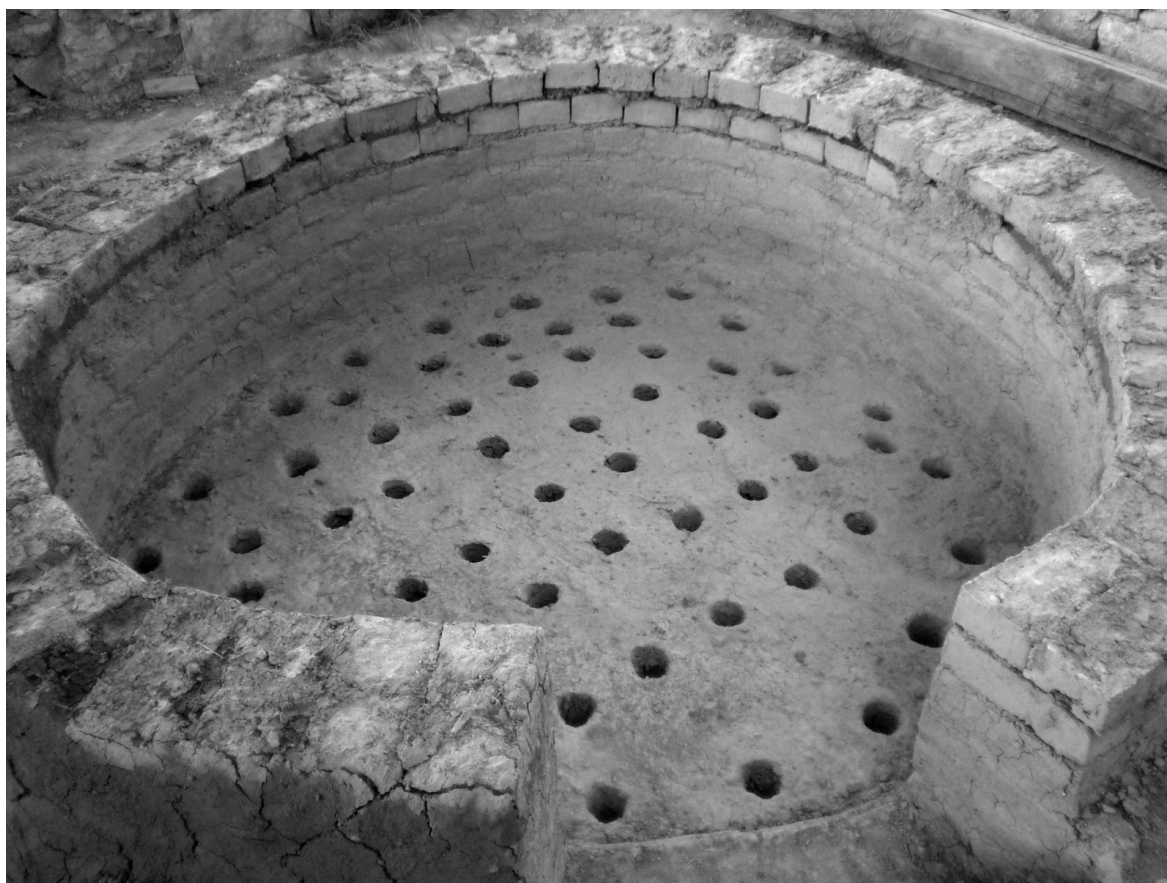
Figura 2. El forn de Verdú amb la graella acabada i inici de construcció de la cambra de combustió.
