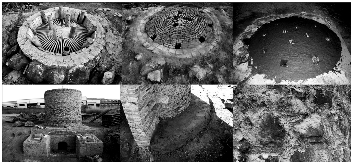
Figura 4. (Arriba): Secuencia de construcción experimental de la parrilla. (Abajo): Secuencia de construcción de la cámara de cocción, empleando adobes y llevando a cabo un revestimiento posterior de piedra arenisca. (Foto: Autor).
